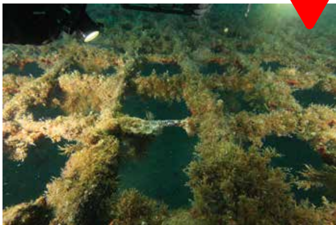
► 2. Inspecting the condition of the metal of the protective cage / Pregled stanja metala na zaštitnom mrežištu (Foto: R. Surić)
