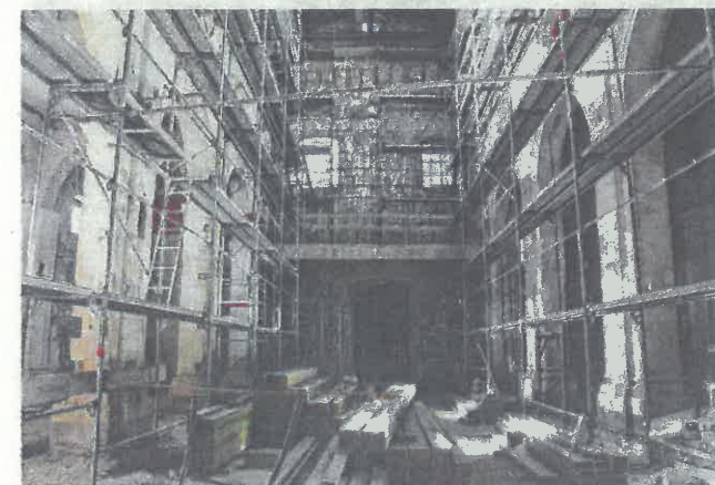
Trenutačno se obavljaju konzervatorski radovi, unutra na kamenoj plastici
