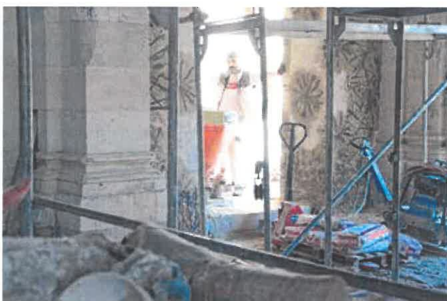
U tijeku su radovi u unutrašnjosti kompleksa
