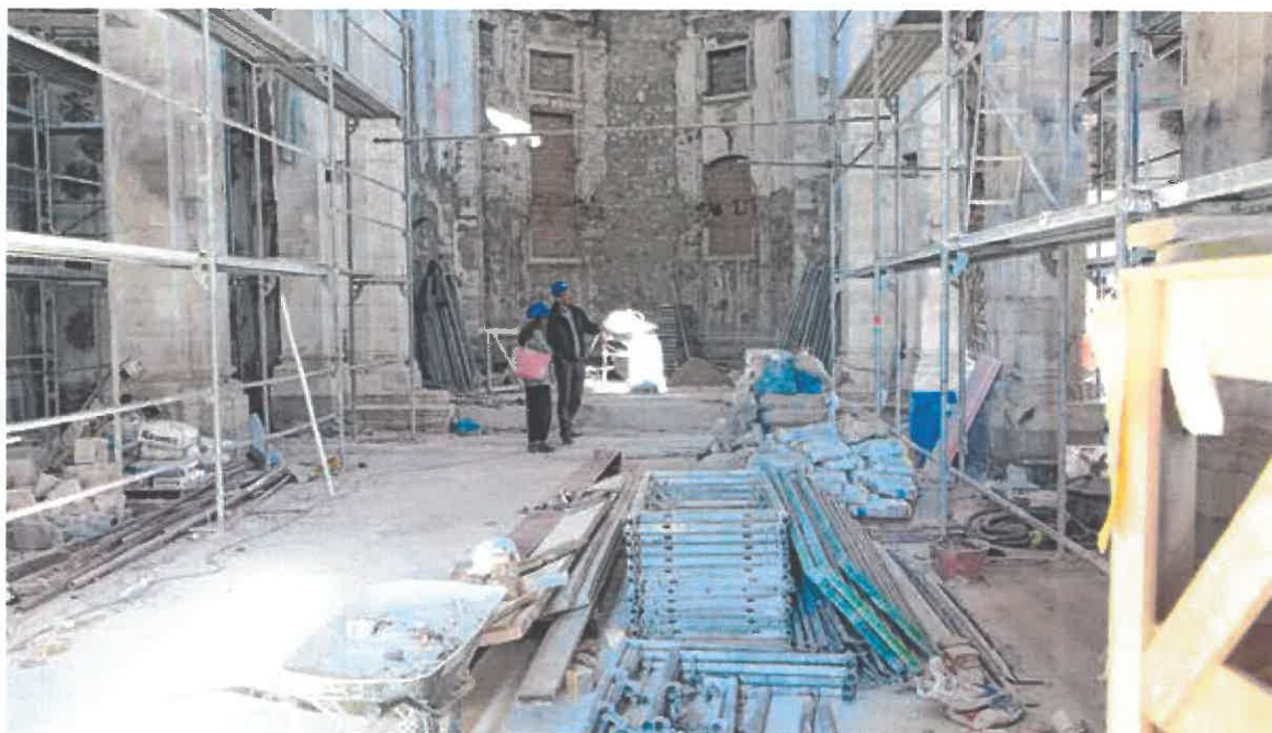
Radovi na obnovi nastavljeni nakon kraćeg prekida
